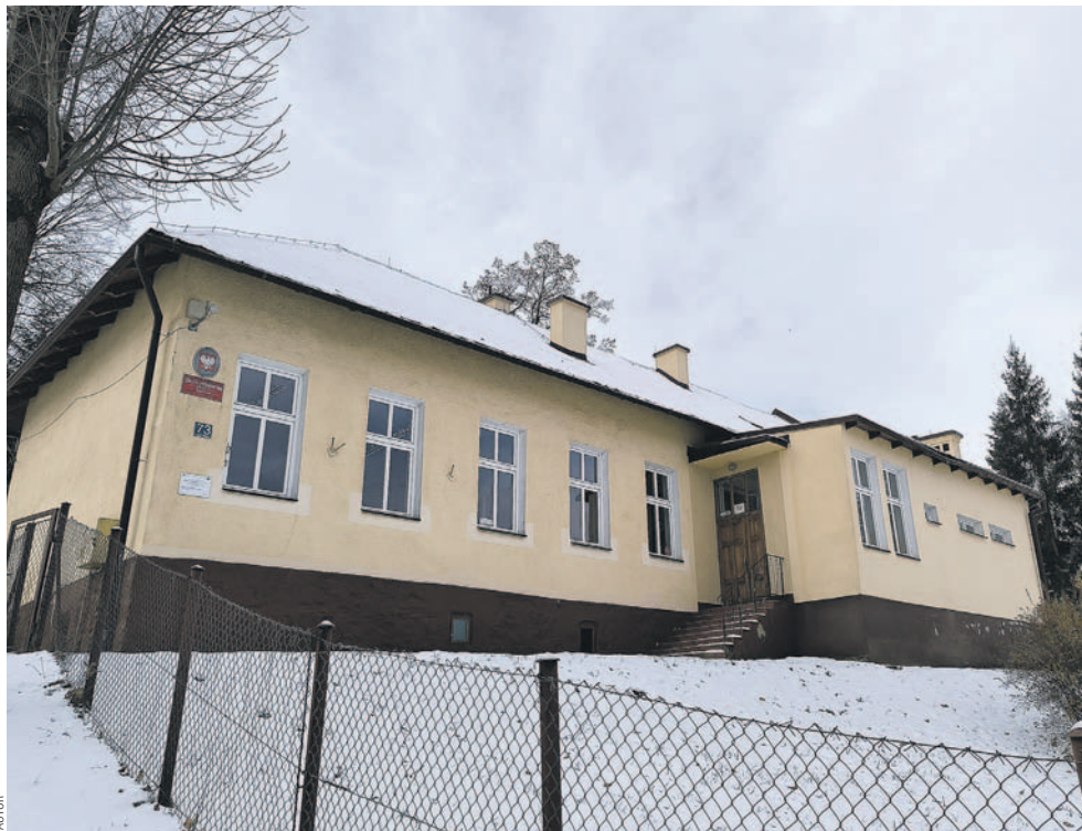
Budynek Szkoły Podstawowej nr 7 przy ul. Piastowskiej
