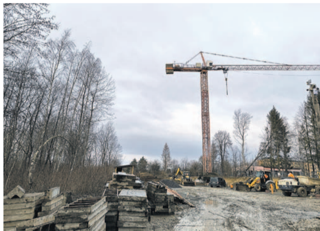
Plac budowy przy ul. Ustrzyckiej
