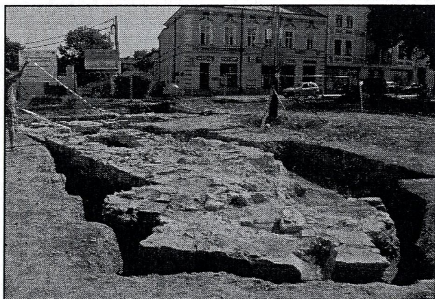
mury ściany wejściowej od strony zachodniej, na pierwszym planie przypora gotycka (fot. ks. T. Grzywna)
