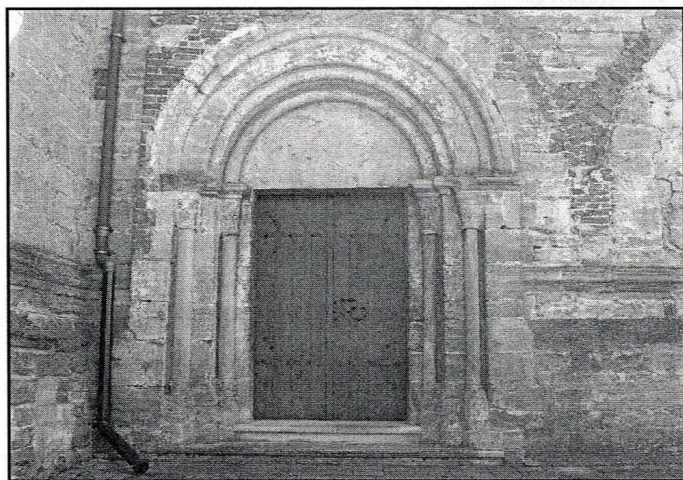
romański portal na północnej ścianie kościoła
