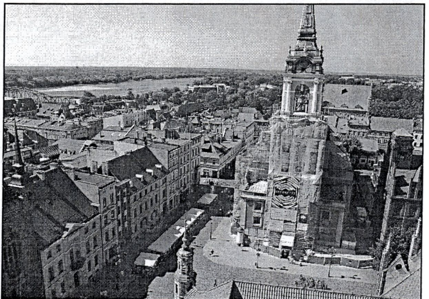
kościół jezuitki św. Ducha przy rynku (remont elewacji) – widok z wieży ratusza
