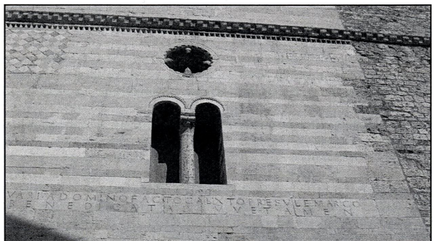
detal fasady głównej - okno w kształcie biforium, nad nim mniejsze, okrągłe i łacińskie napisy
