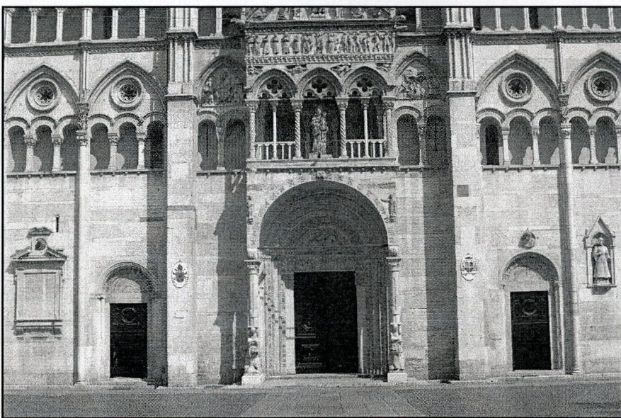
dolna część fasady wraz z portalem i częścią ganku nad nim
