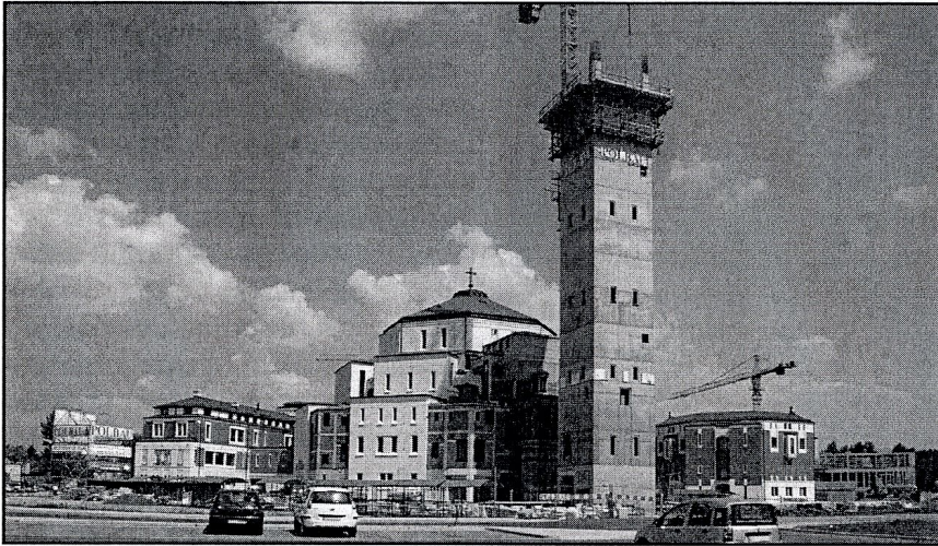
kompleks sanktuarium św. Jana Pawła II w budowie
