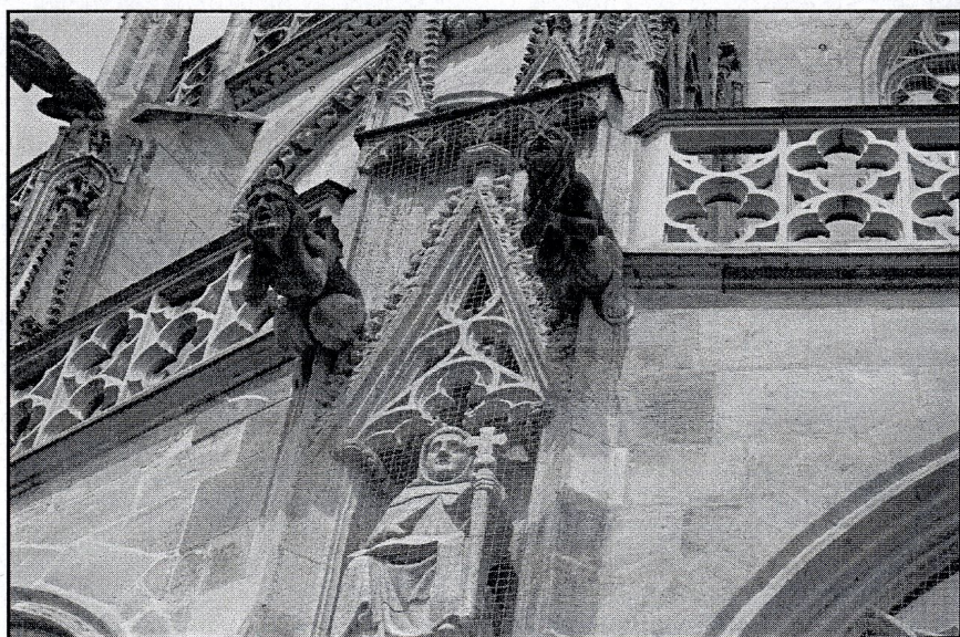
figura mnicha i gargulce odprowadzające wodę
