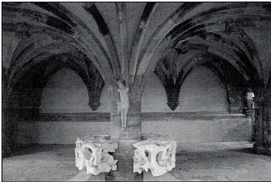
otarta od zewnątrz krypta pod prezbiterium
