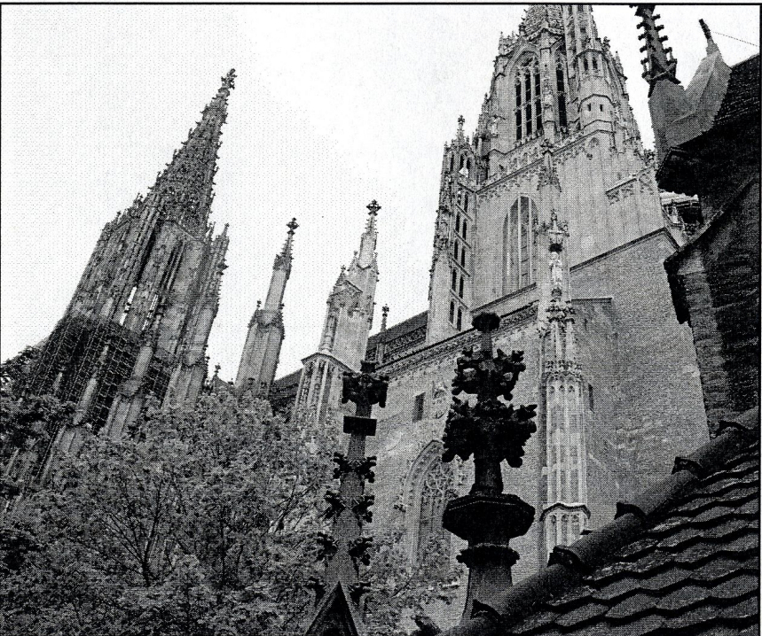
iglice katedry widoczne od strony południowej
