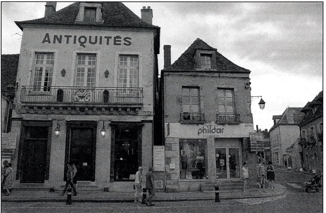
budynki w miastach najczęściej nie są odnowione
