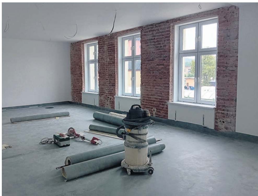
Prace remontowe na piętrze budynku
