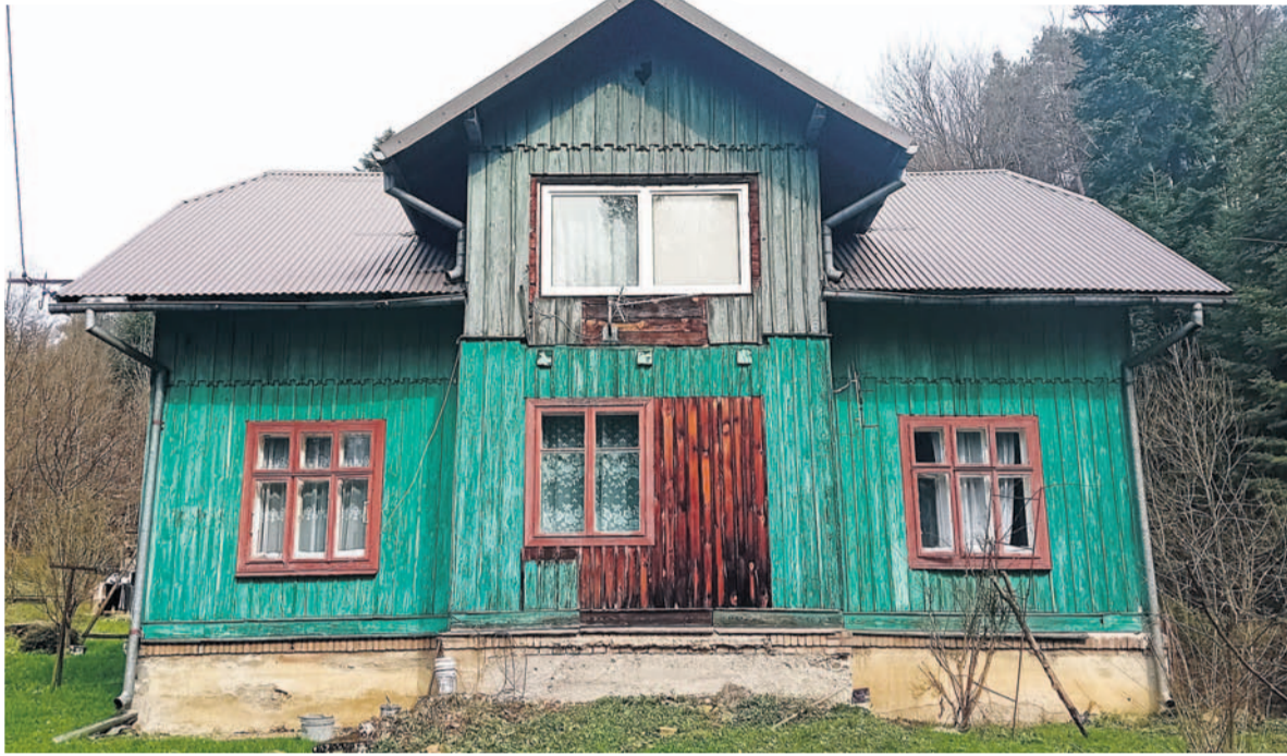
Budynek dawnej leśniczówki
