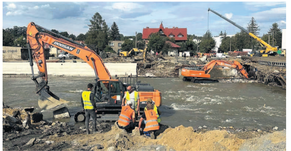
Po przejściu fali rozpoczęły się naprawy i prace porządkowe
