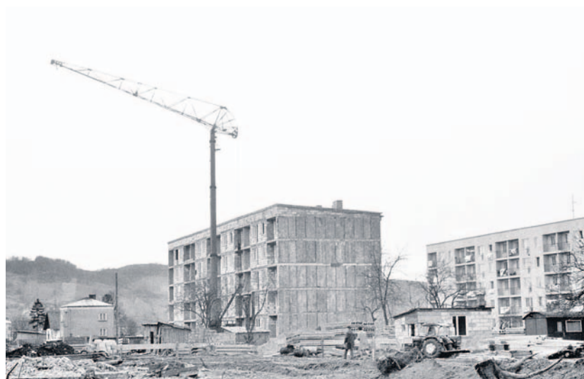
Budowa osiedla Traugutta, 1973 r.
