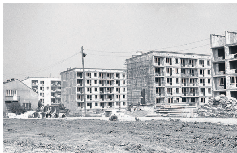
Budowa osiedla Traugutta, 1972 r.
