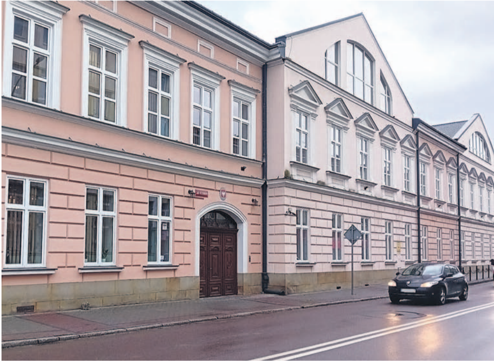
Gmach sądu z odnowionymi niedawno wrotami wejściowymi
