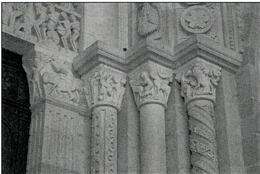
dekoration obramowania portalu – głowice potrójnych kolumn
