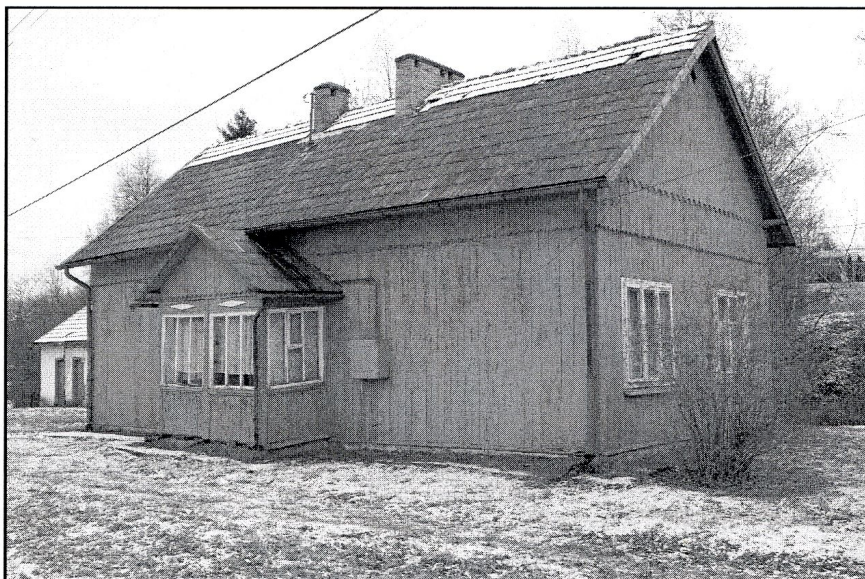
budynek dawnej szkoły w Płowcach pamiętający lata przedwojenne
