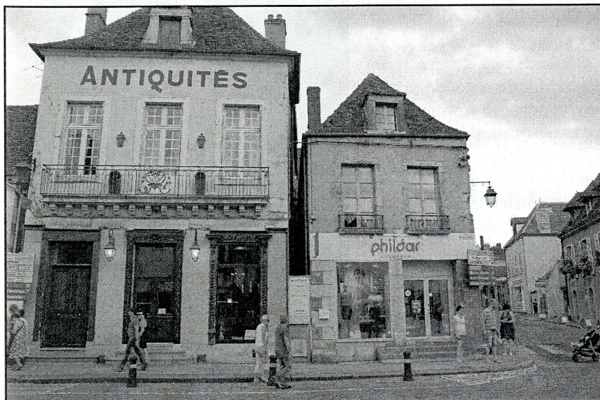
budynki przy jednej z ulic miasteczka, widoczne odrapania na ścianach
