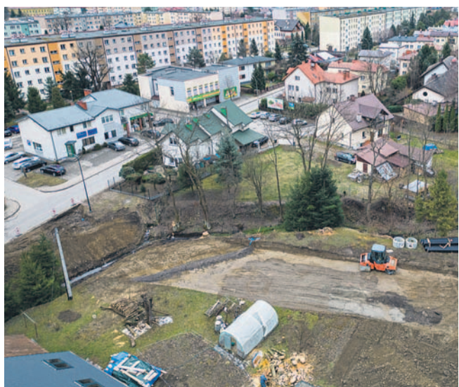
Trwają prace przy ulicy Zagumnej
