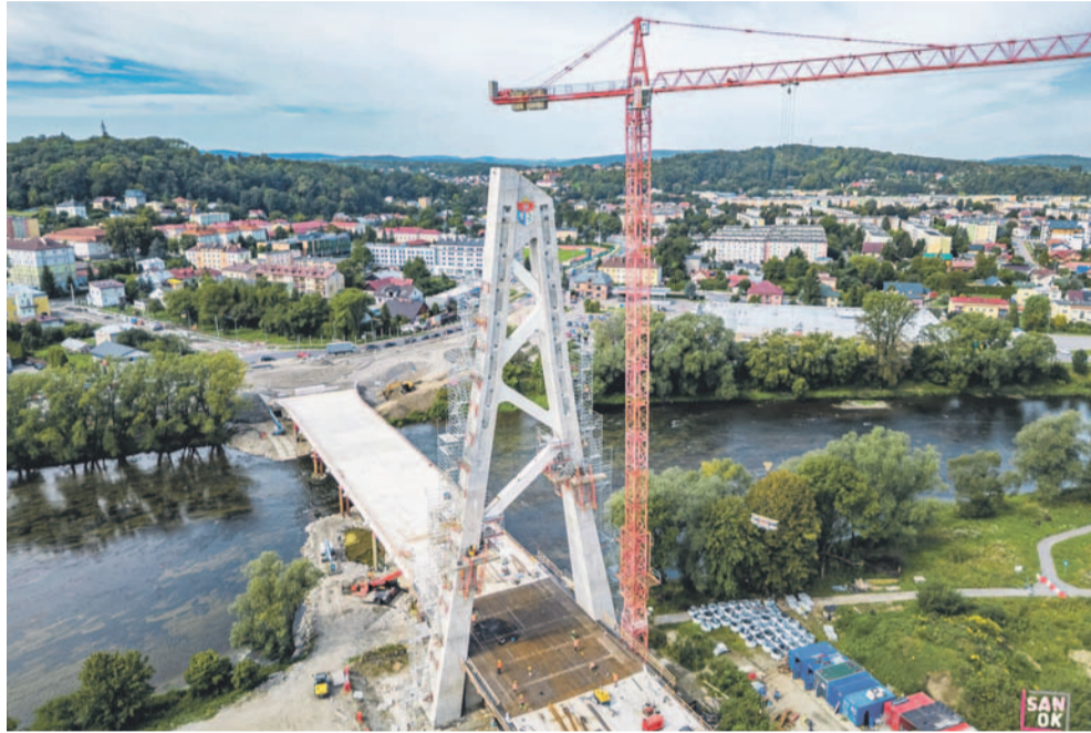
Budowa mostu na Sanie
